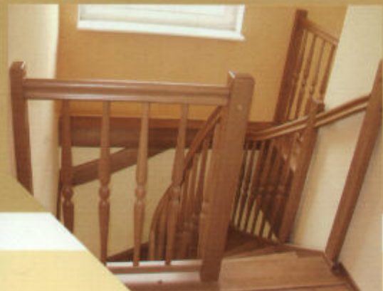
1/2 gew. Treppe aus Buche gedämpft mit Krümmlingspfosten sowie eine Blockstufe
