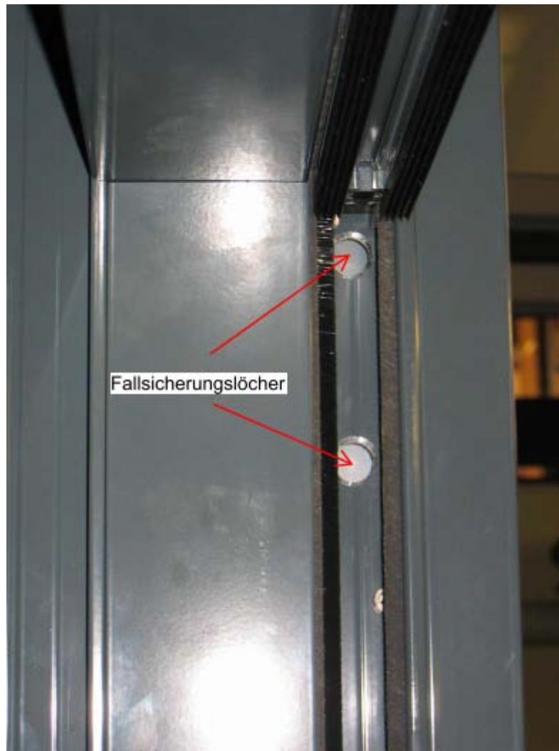
seitliche Verschraubung durch Fallsicherungslöcher
