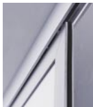
Montage unter der Decke.
