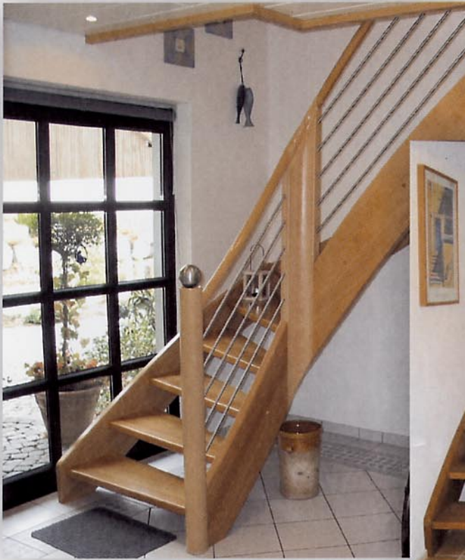
■ eingestemte Wangentreppe, Buche, mitlaufende Edelstahlstäbe
