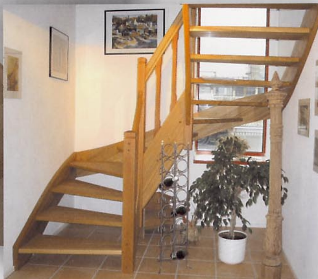
■ eingestemmte Wangentreppe, Lärche, Sonderstab
