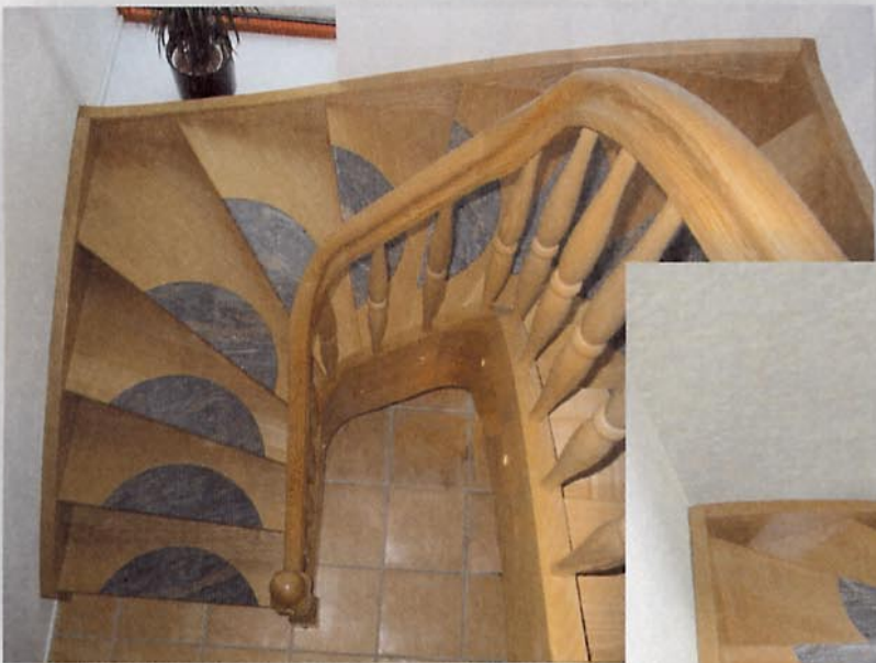
■ eingestemmte Wangentreppe, gedrehter Stab, Stufen mit Graniteinlage
